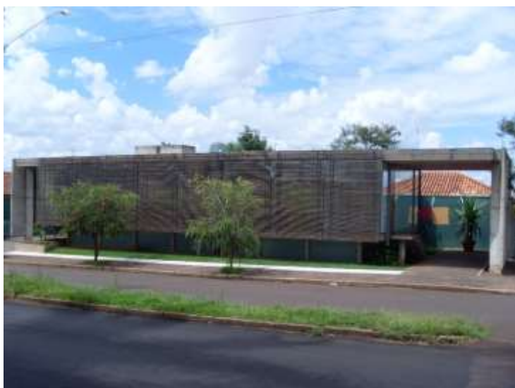
Figura 08 – Clínica de Odontologia, 1998-2000, edifício e entorno (4). Fonte: autor (mar. 2008).
