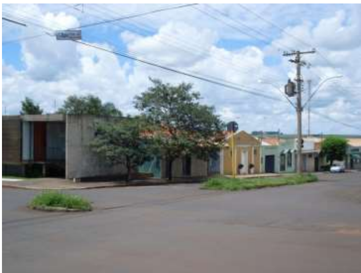
Figura 07 – Clínica de Odontologia, 1998-2000, edifício e entorno (3). Fonte: autor (mar. 2008).
