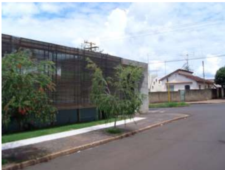
Figura 05 – Clínica de Odontologia, 1998-2000, edifício e entorno (1). Fonte: autor (mar. 2008).
