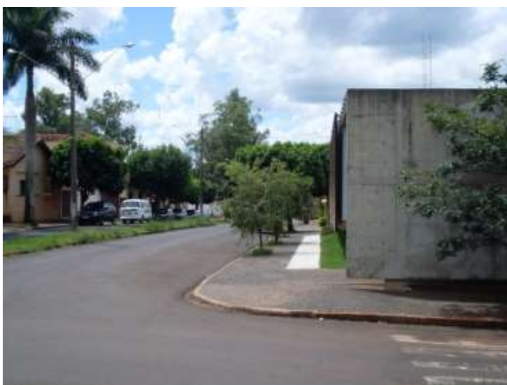
Figura 06 – Clínica de Odontologia, 1998-2000, edifício e entorno (2). Fonte: autor (mar. 2008).
