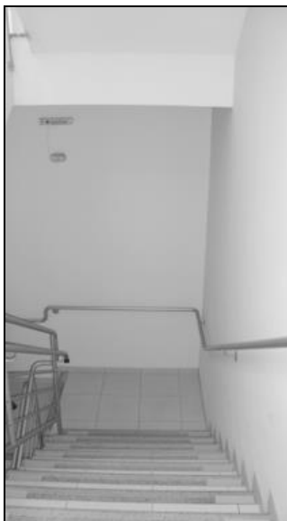
Fotos 05 e 06: Detalhe para o trabalho no piso para criar atrito e funcionar como faixa antiderrapante, no corrimão que segue a altura, sua continuidade na parede e o vão livre da escada próximo a 3,0 metros (Denis Gastaldi, 2012)
