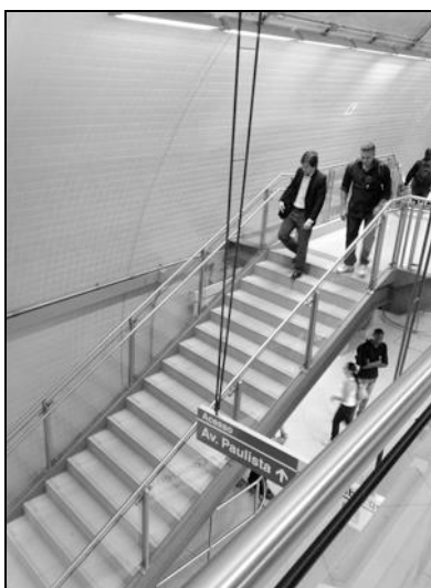
Foto 08: Escada da Linha Amarela – Detalhe para duas alturas de corrimão e outros elementos de segurança (Denis Gastaldi, 2012)
