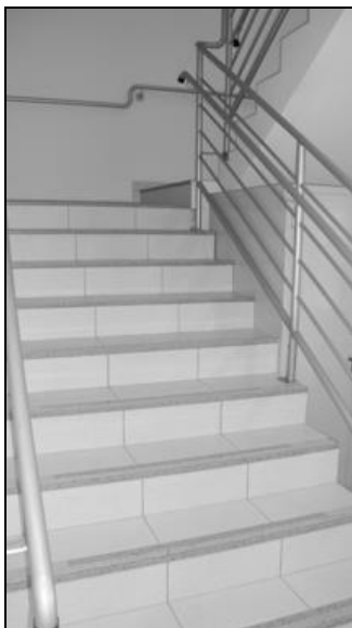
Fotos 05 e 06: Detalhe para o trabalho no piso para criar atrito e funcionar como faixa antiderrapante, no corrimão que segue a altura, sua continuidade na parede e o vão livre da escada próximo a 3,0 metros (Denis Gastaldi, 2012)
