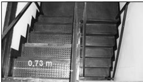
Foto 01: Escada da Câmara vista de cima – largura da escada (Denis Gastaldi, 2011)
