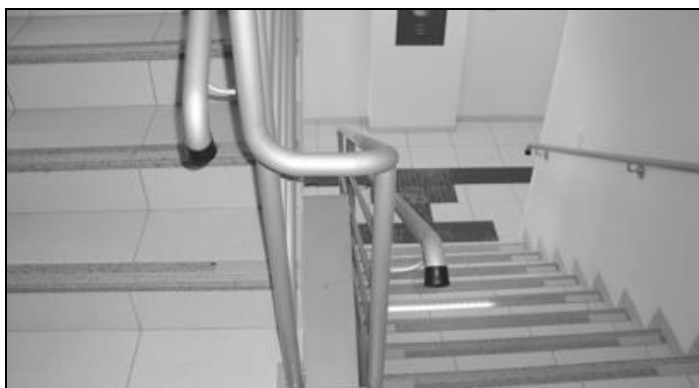
Foto 07: Detalhe para o momento em que o guarda-corpo se torna corrimão, mantendo-se a altura padrão e garantindo a estabilidade do usuário ao utilizar o espelho que divide os patamares dos lances da escada (Denis Gastaldi, 2012)
