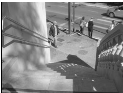
Fotos 10 e 11: Lado direito da escada – Detalhe para corrimão implantado na escada já existe para garantir a segurança do usuário no espaço de circulação vertical (Denis Gastaldi, 2012)
