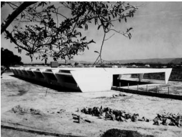
Figura 08 – Ginásio de Itanhaem, 1959, vista exterior. Fonte: Artigas (1997, p. 90).
