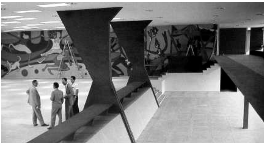
Figura 10 – Ginásio de Guarulhos, 1960, detalhe interior. Fonte: Artigas (1997, p. 91).
