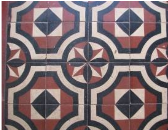
Figura 2: Piso hidráulico de uma atual casa comercial, em estilo colonial, localizada na Praça do Coreto, Cidade de Goiás. 2010.
