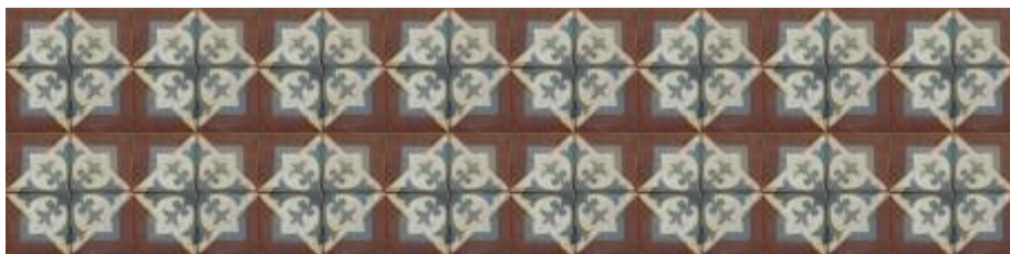
Figura 8: Ladrilho hidráulico assentado no alpendre e sala de visitas da sede da Fazenda Barreiro.
