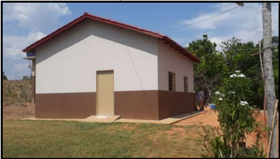
Figura 4 – Edifício construído com recursos do PNHR (PA Imperatriz - Amaralina), Goiás, setembro de 2018.
