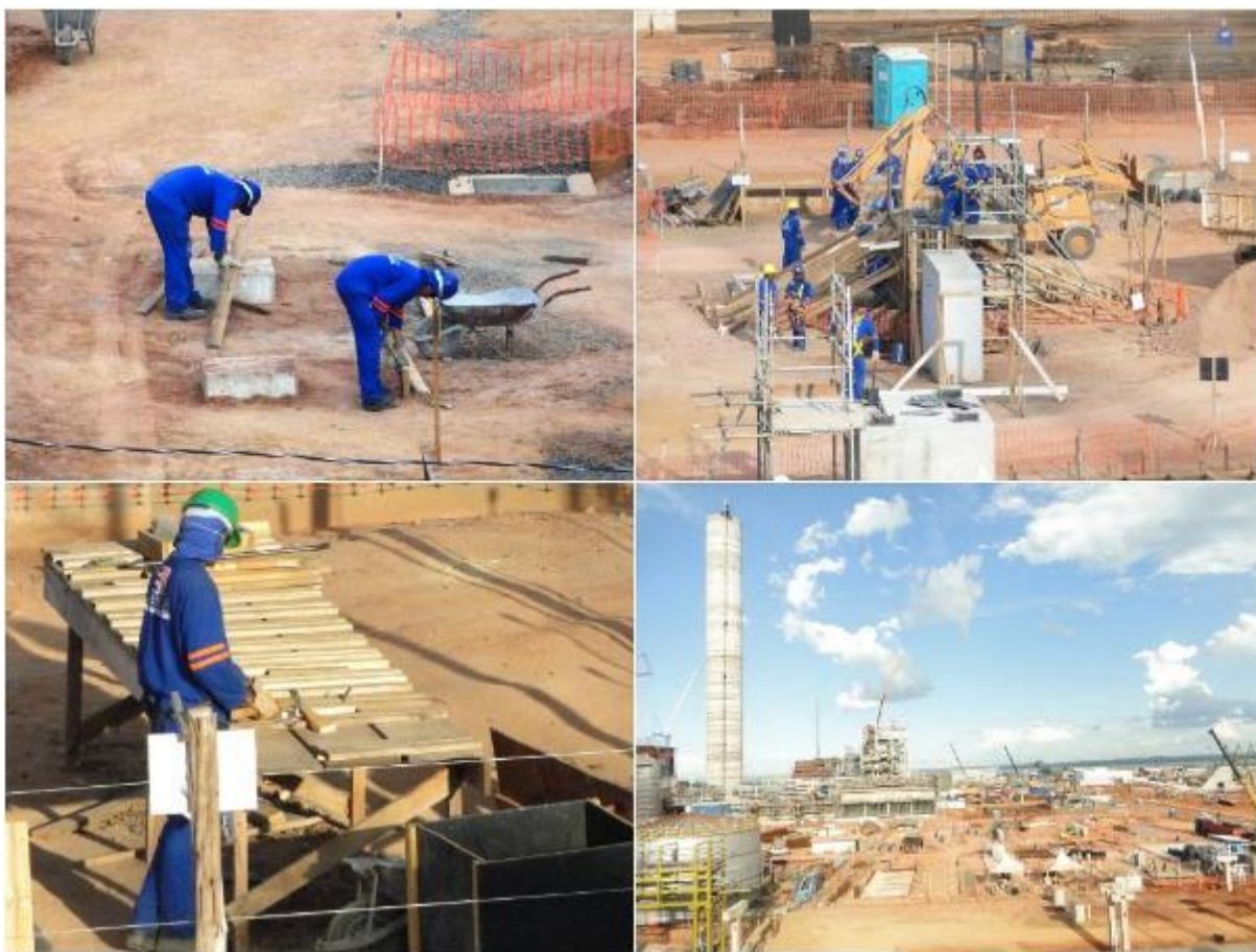
Figura 03 – Município de Três Lagoas/MS - imagens da construção/montagem da fábrica da Eldorado Brasil – 2012.
