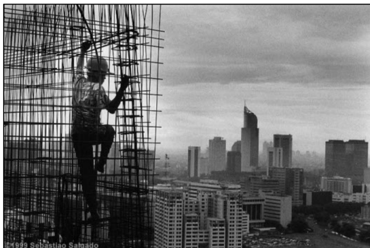
Figura 1: Trabalhador na construção civil (Sebastião Salgado). Fonte: http://www.sebastiaosalgado.com.br/ , acesso em 03/07/2009.
