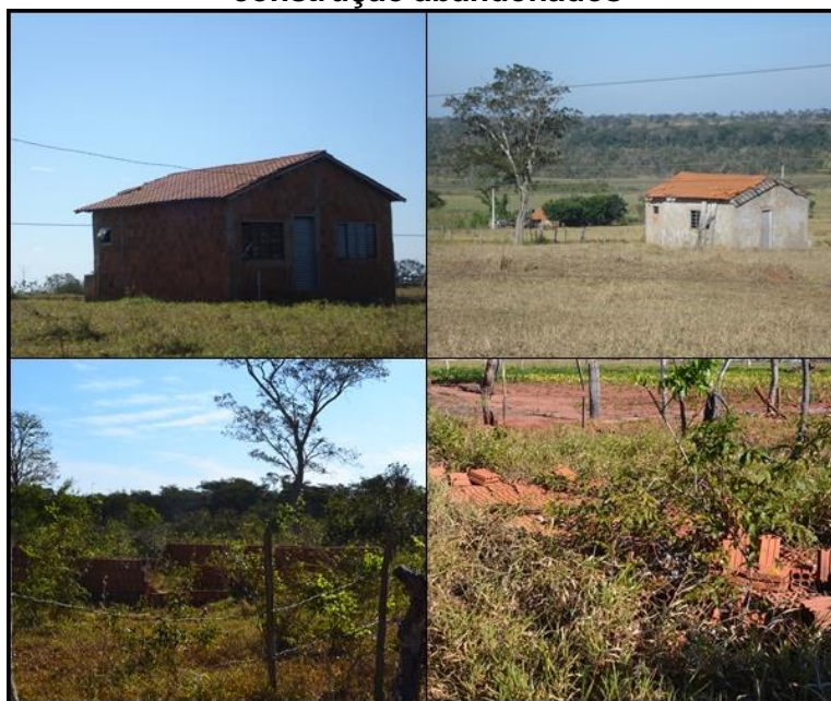
Figura 2- Assentamento Paulistinha/Três Lagoas (MS): casas e materiais para construção abandonados
