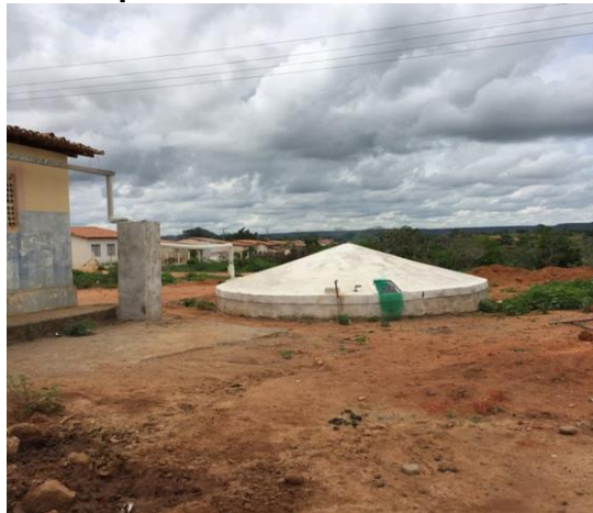
Figura 03 – Cisterna de placas construída nas escolas e casa de farinha
