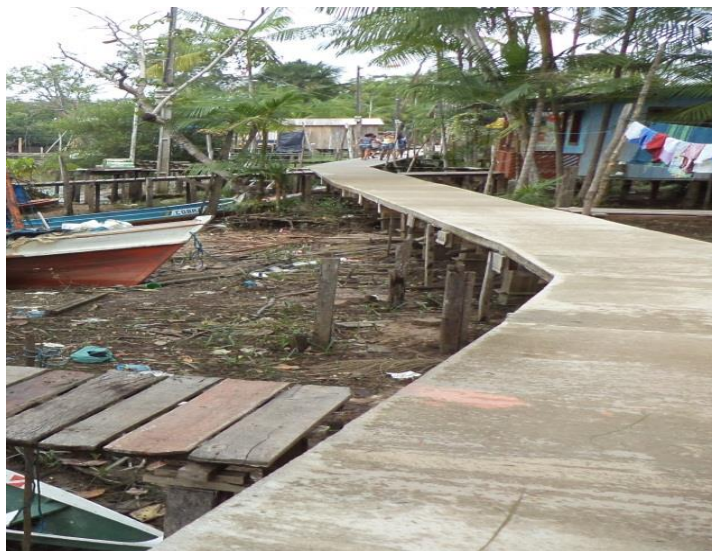
Figura 3: Passarelas de concreto construídas pelos moradores
