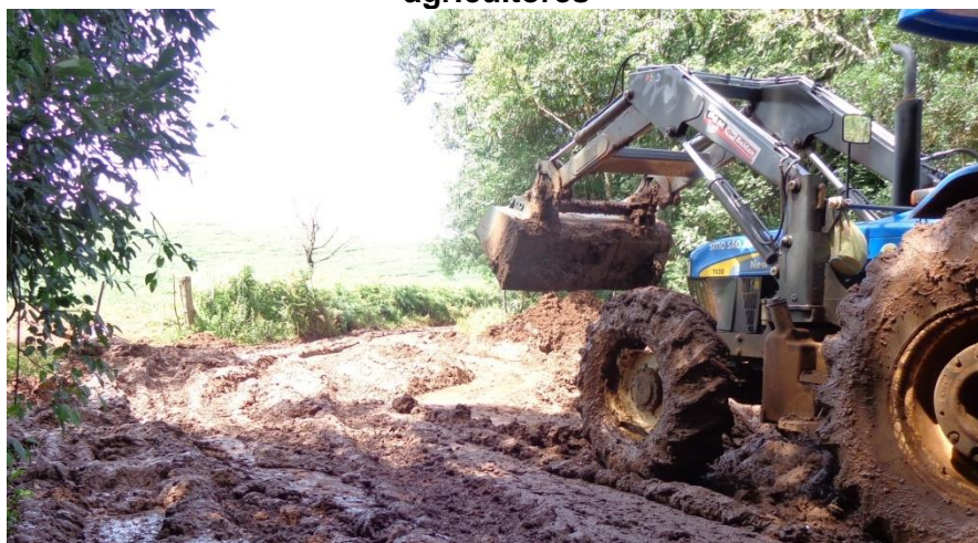
Figura 5 – Estrada secundária, com manutenção sendo feita pelos próprios agricultores
