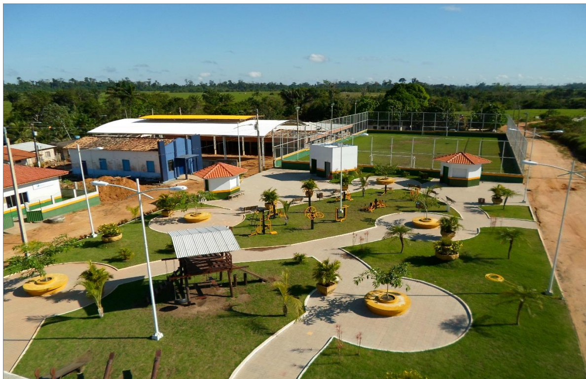
Figura 3: Comunidade Cilo Bananal após reforma em 2015
