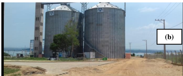
Figura 2: Porto da Caramuru Alimentos, a margem Esquerda do rio Tapajós, Itaituba.
