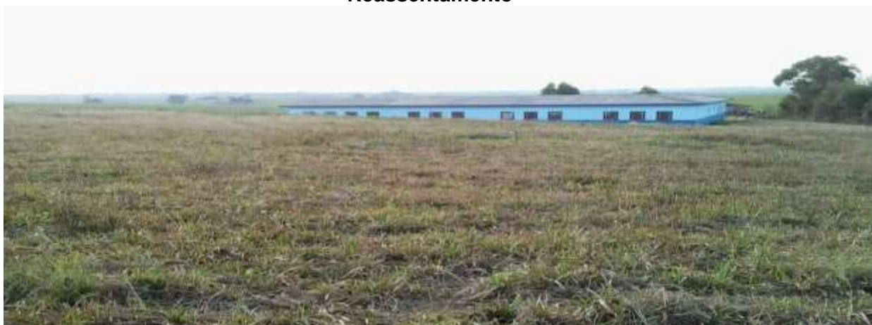
Figura 04 - Escola Municipal de Ensino Fundamental localizada no Reassentamento
