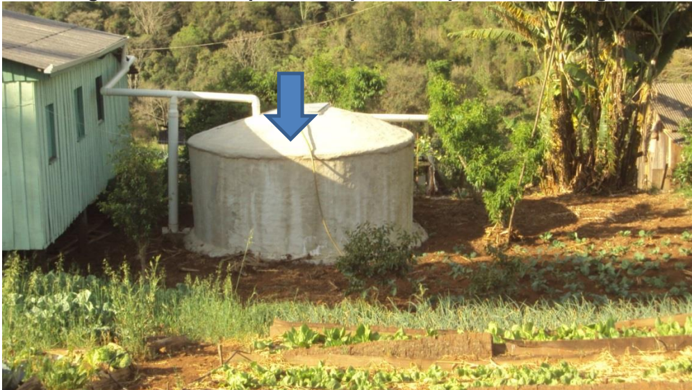
Figura 5: Mangueira instalada para acompanhar a quantidade de água da cisterna
