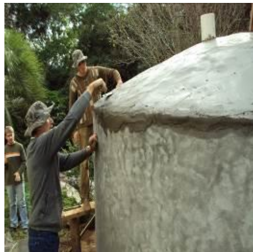
Figura 11: Fixação da massa
