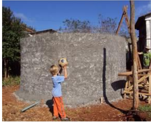
Figura 4: Parede com massa
