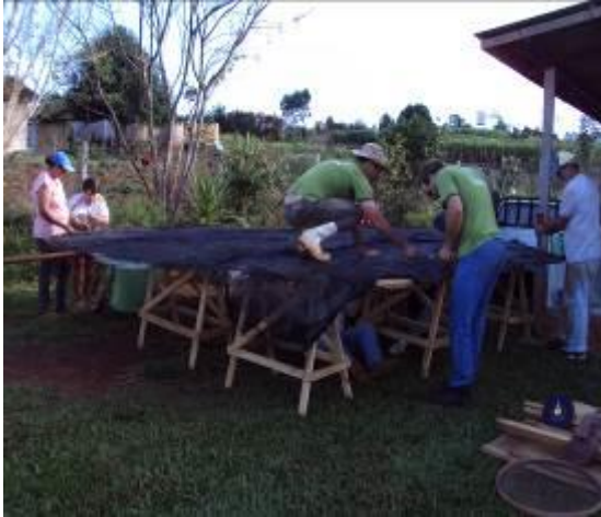
Figura 6: Construção do topo
