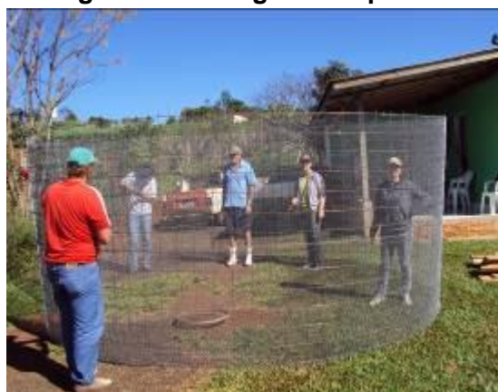
Figura 2: Montagem das paredes
