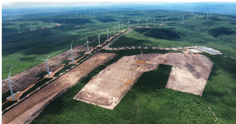
Figure 2: Ventos de Santa Eugênia Hybrid Wind-Solar Complex.
