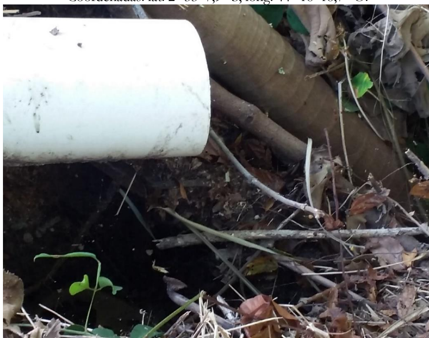
Figura 07. Ponto de despejo de esgoto no interior da Cidade Universitária Dom Delgado. Coordenadas: lat. 2° 33' 7,9" S, long. 44° 18' 18,7" O.
