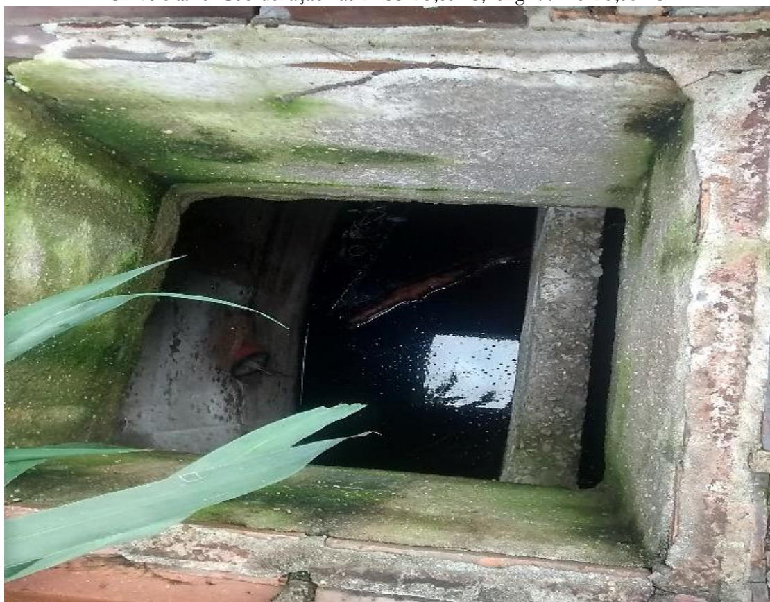
Figura 08. Sumidouro sem tampa e com vazamento situado em frente ao Restaurante Universitário. Coordenação: lat. 2° 33' 23,85" S, long. 44° 18' 25,86" O.
