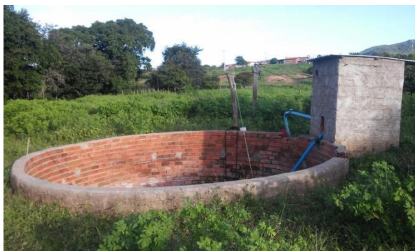
Figura 3. Poço tipo cacimbão
