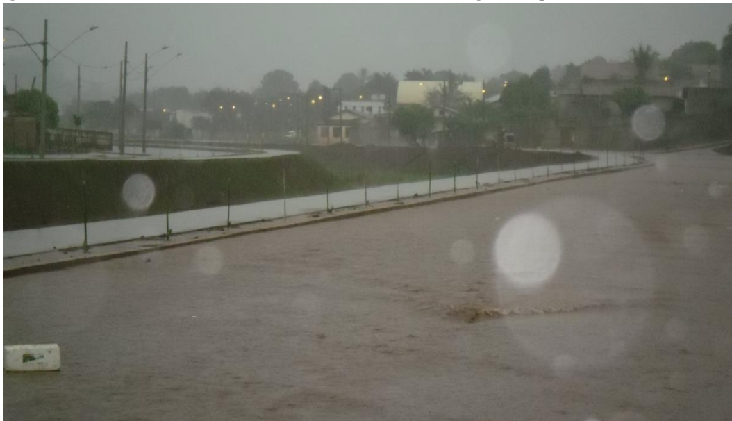
Figura 3: Ituiutaba-MG. Enxurrada na malha asfáltica as margens da parte de canalização aberta.
