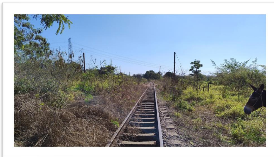
Figura 5 – Remanescente de infraestrutura ferroviária
