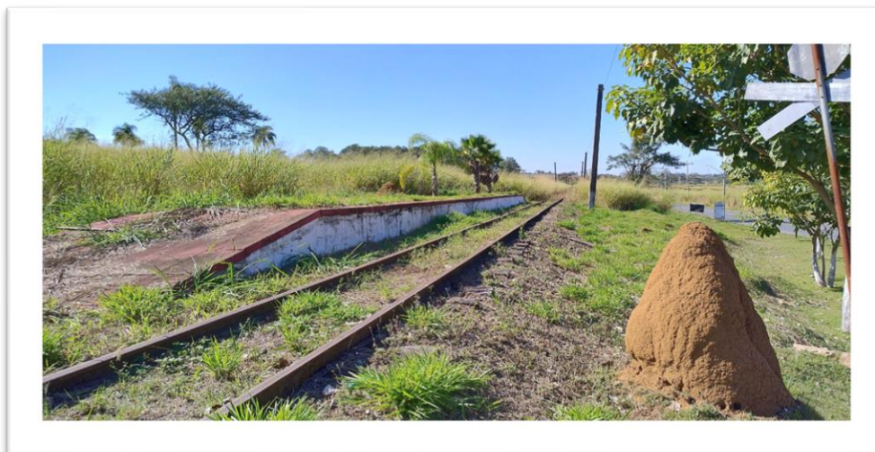
Figura 4 – Remanescente da plataforma da antiga Estação Bela Vista
