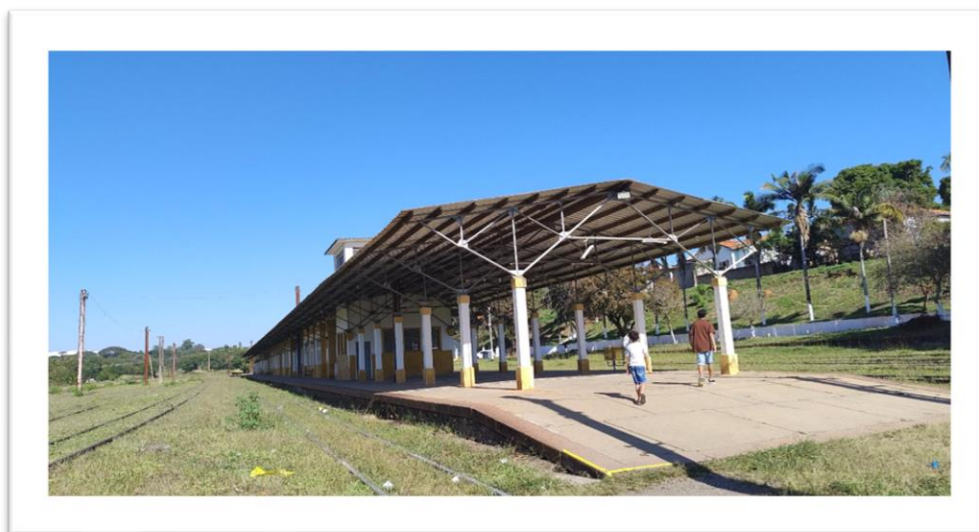
Figura 2 – Pátio Ferroviária de Iperó e Estação ferroviária
