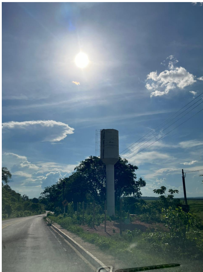
Figura 5 – Caixa d'água do poço artesiano de Mimoso
