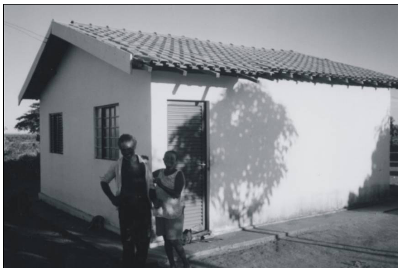
Figura 8: Casa construída pela CESP. Fonte: SOUZA, 2004.
