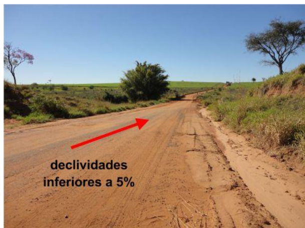
Figura 13 -Vertentes com declividades inferiores a 5%. Foto: dos autores, trabalho de campo, agosto de 2014.
