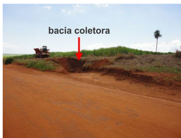
Figura 8 - Maquinário agrícola para implantar bacias coletoras. Ao fundo, cultivo de cana de açúcar. Foto: dos autores, trabalho de campo, fevereiro de 2014.
