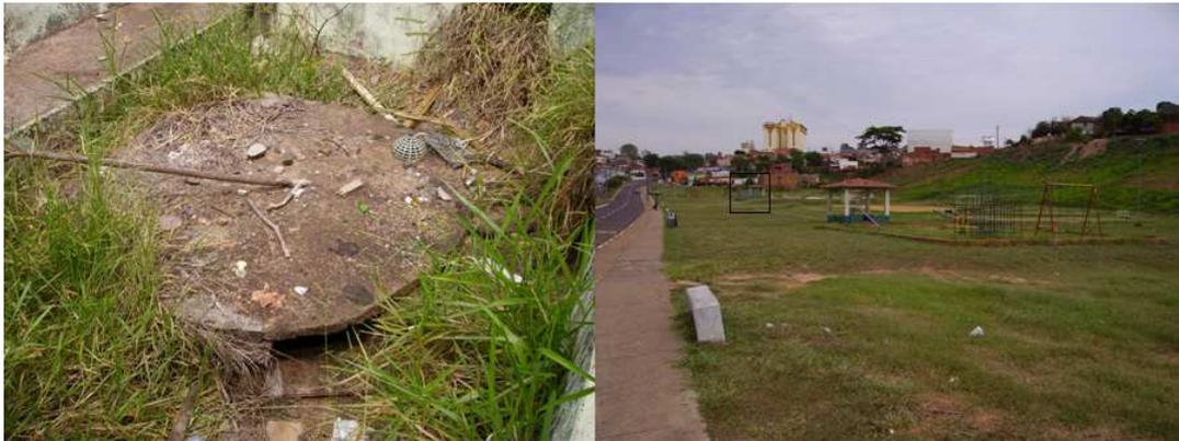
**Foto 4.** Exemplo de poço de visita sem inspeções e sua localização, na Av. Tancredo Neves.
