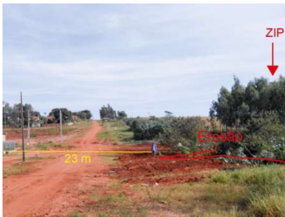
FIGURA 6: Aterramento da feição erosiva em área urbana. Fotografia: Autor. Data: (25/06/2014).
