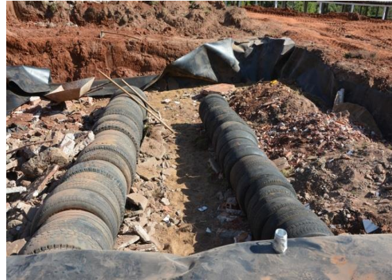
Figura 04b. Instalação de duas linhas de pneus formando câmaras de recebimento de efluentes. Detalhe para o preenchimento com entulho de construção.
