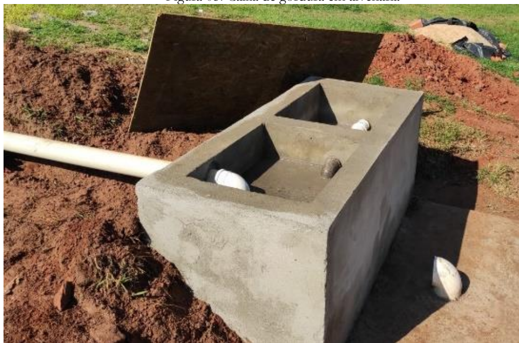
Figura 05. Caixa de gordura em alvenaria
