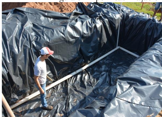
Figura 06a. Impermeabilização com lona plástica. Detalhe para tubulação coletora (fundo) e tubulação lateral para monitoramento e saída do excedente.
