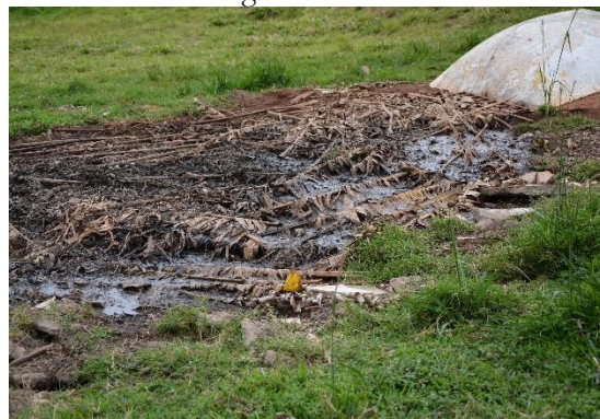
Figura 8b. Transbordamento da antiga fossa negra existente na CTR.
