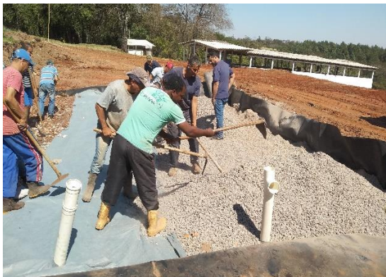
Figura 04c. Distribuição da pedra brita sobre a manta geotêxtil. Detalhe para os tubos de amostragem instalados sobre as câmaras de pneus.
