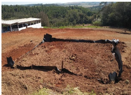
Figura 04e. Bacia de evapotranspiração concluída e camada de solo sobre a areia.
