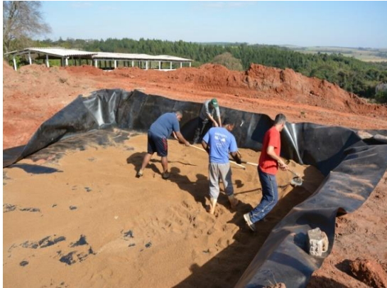
Figura 04a. Instalação da geomembrana e preparo do fundo com areia grossa para recebimento do entulho.
