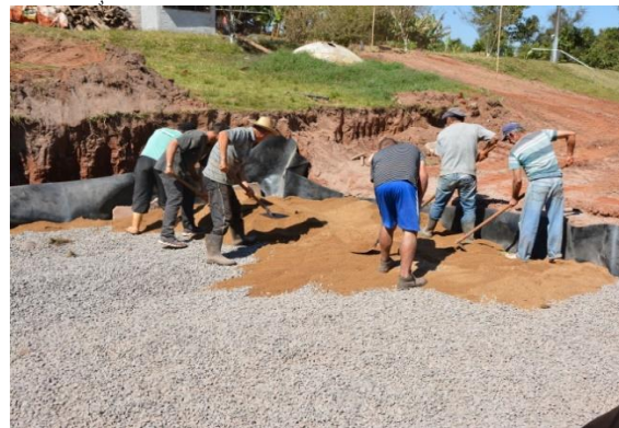
Figura 04d. Distribuição da areia sobre a pedra brita.
