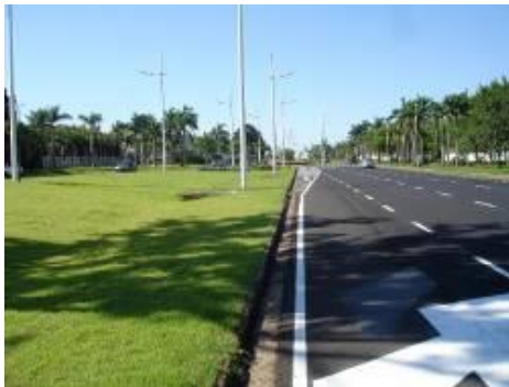
Figura 1. Canteiro central da avenida Anísio Haddad.
