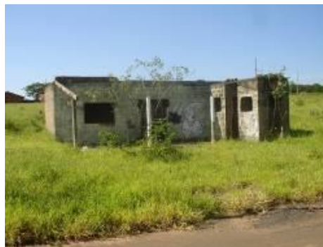
Figura 16. Obra abandonada no interior do Auferville III.
