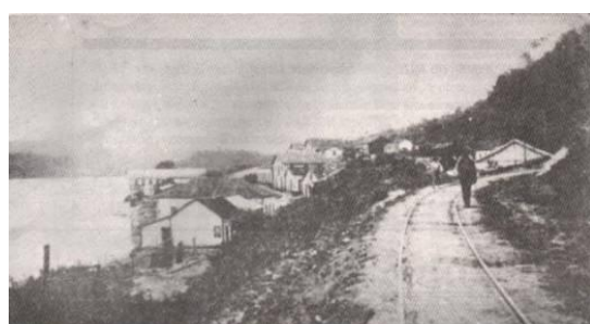
Foto 1: 1907 – Estrada de Ferro Vitória-Minas e primeira aglomeração urbana em Colatina.
