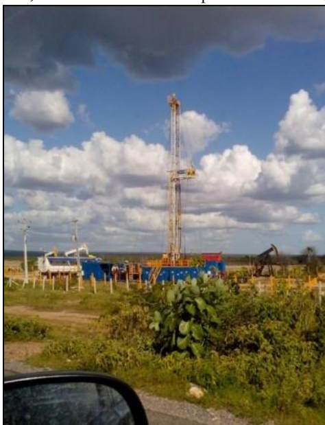
Figura 3. Sonda de perfuração em operação no Campo de Canto do Amaro, nas proximidades da BR-110, zona rural do município de Mossoró/RN
