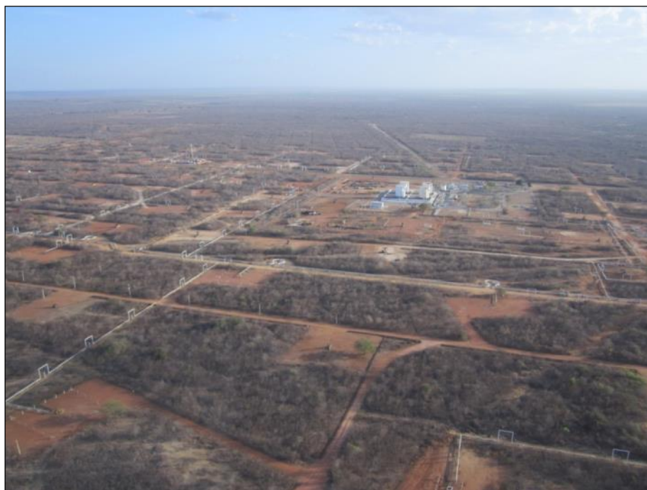
Figura 5. Vista aérea das redes técnicas no município de Alto do Rodrigues
