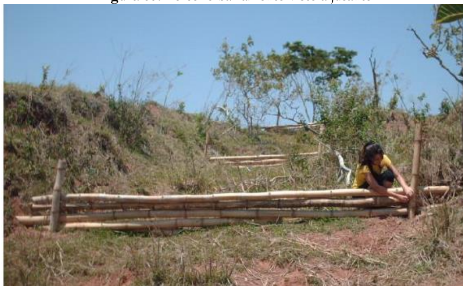
Figura 07. Terceiro barramento visto à jusante
