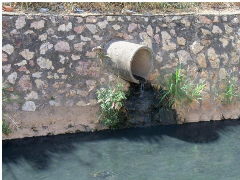
**Foto 03** - Canalização para lançamento de esgoto no Córrego do Gambá.
