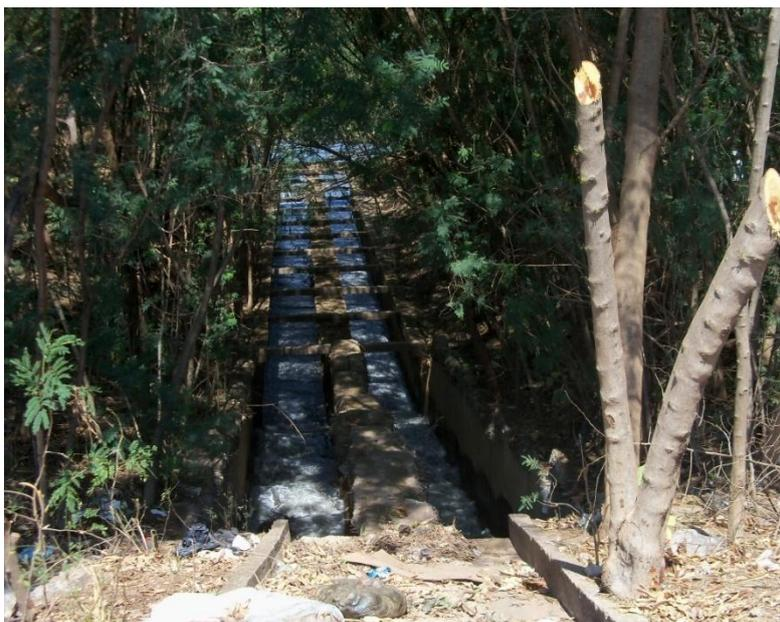
**Foto 04** - Sistema de canalização com dissipadores de energia no foz do Rio Cuiabá.
