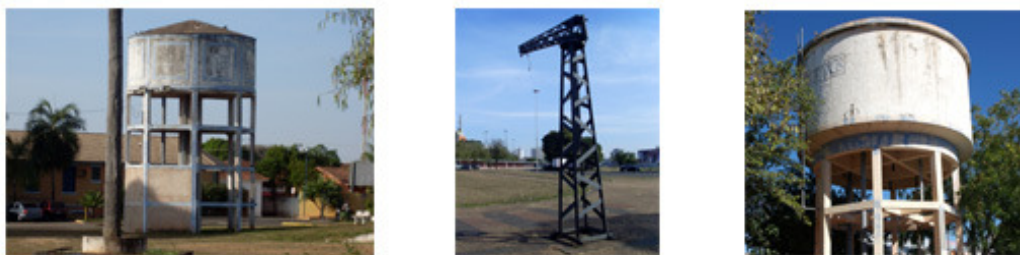
Figura 9 – (a) (b) (c) Rastros da ferrovia ao longo da Avenida dos Araçás (Evandro Fiorin, 2012)
