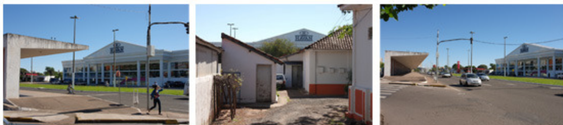
Figura 10 – (a) (b) (c) HAVAN, na Avenida dos Araçás, defronte à antiga estação modernista (Evandro Fiorin, 2012)
