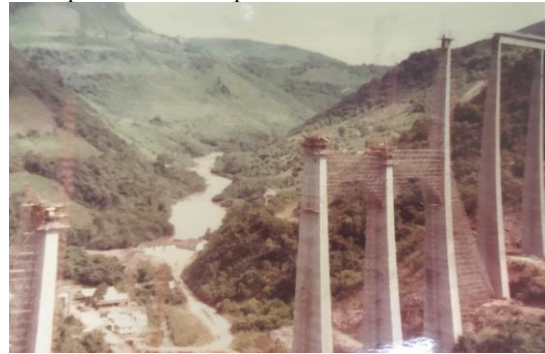
Figura 09. Viaduto 13 em construção com vista para o rio Guaporé
