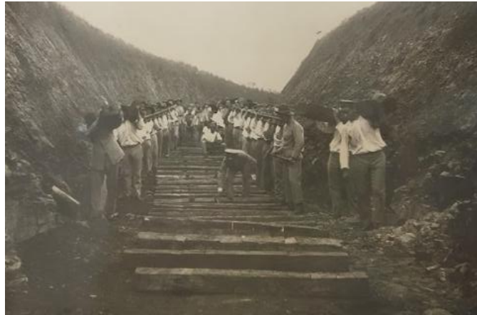
Figura 06. Assentamento de trilhos e dormentes de madeira em corte de solo.
