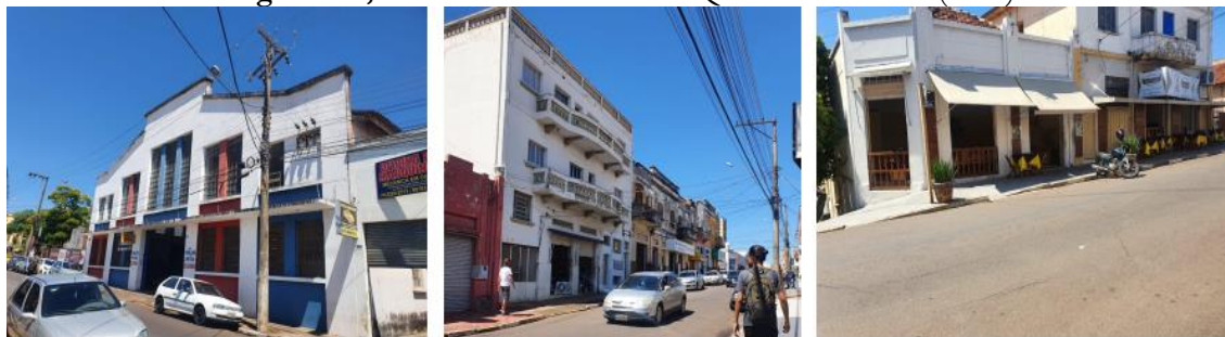
Figuras 12, 13 e 14. Edifícios na Rua Quintino Bocaiúva (2023)
