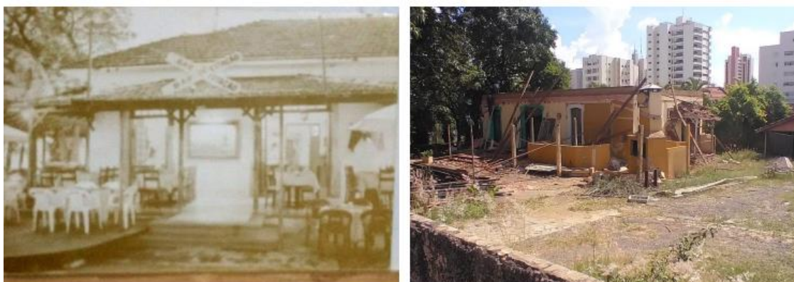
Figuras 04 e 05. Antiga casa do engenheiro chefe transformada no Bar da Estação em 2014 e imóvel demolido em 2022
