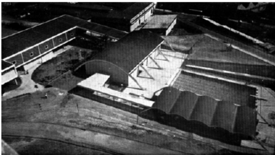
Figura 10: Foto do Conjunto Pedregulho – Vista do Ginásio. Fonte: Revista Habitat, abril de 1956, nº 29
